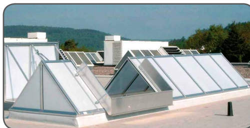
JET-VARIO-Sattel-Lichtband-Vollklappe 130° öffnend
