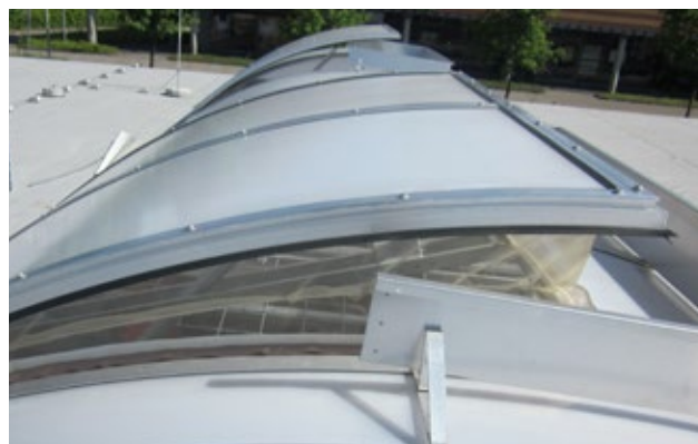
JET-Lichtband-Klappe in Lüftungsstellung mit Insektenschutzsystem
